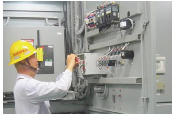
發輸配電系統保護電驛維護試驗實況
