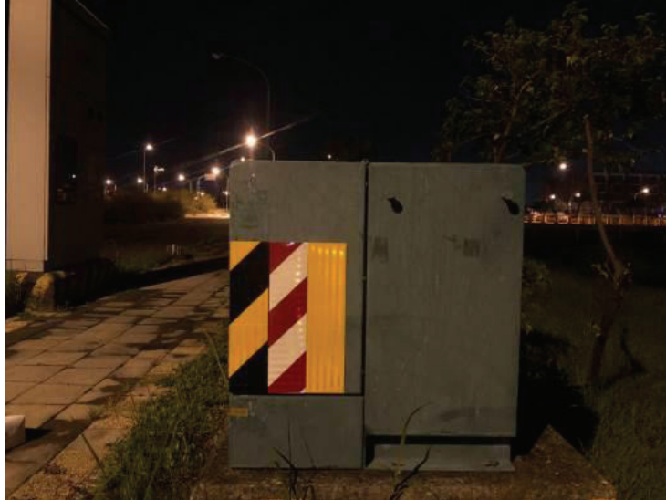
圖 1 亭置式設備張貼反光片示意圖
