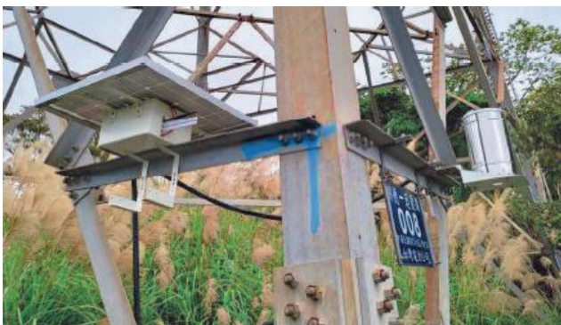
圖 2 小型氣象站 (安裝於鐵塔下，用於蒐集現場之風速、風向與雨量等氣象資訊，以供計算動態熱容量。)
