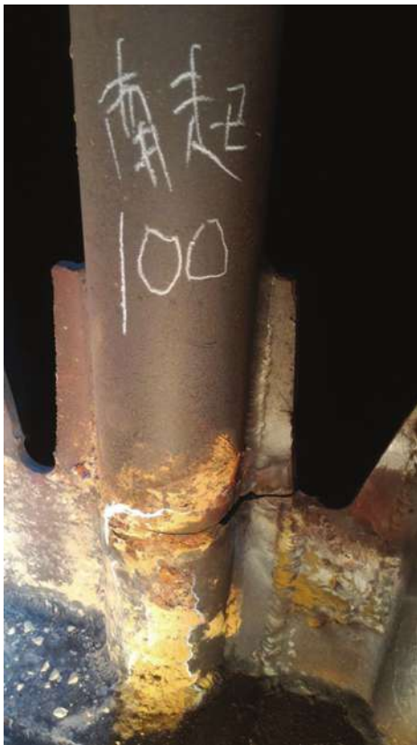
圖 1 補強管路龜裂情形
