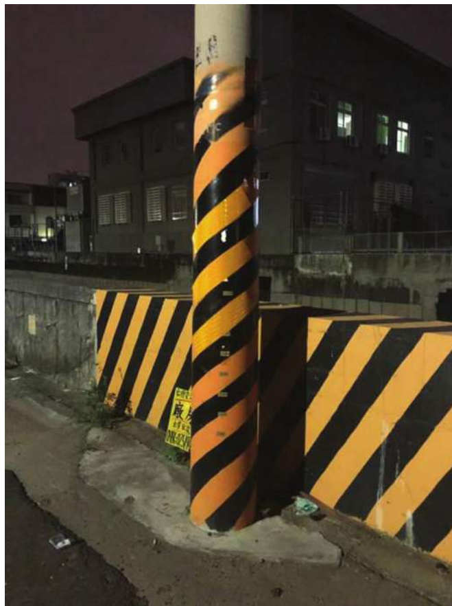
圖 2 電桿張貼反光片示意圖
