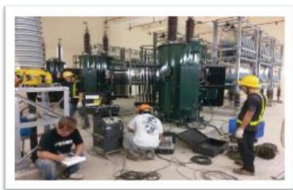
板新 P/S 69kV 電抗器測試 (108.08)
