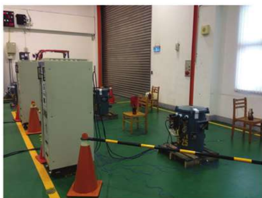
配電變壓器溫升試驗
