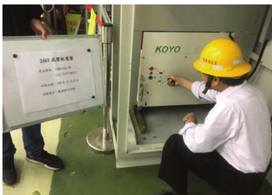
配電盤實驗室
