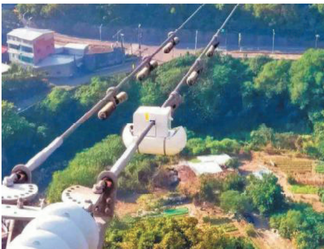
圖 1 動態熱容量監測設備 (安裝於輸電線上，用以量測線路之線溫、線電流及線路弛度等監測資料。)
