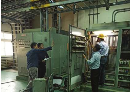
大潭發電廠 5 號機大修電氣儀表校驗
