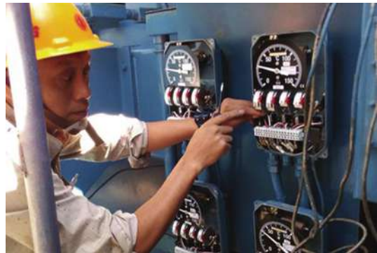
主變壓器溫度開關試驗實況
