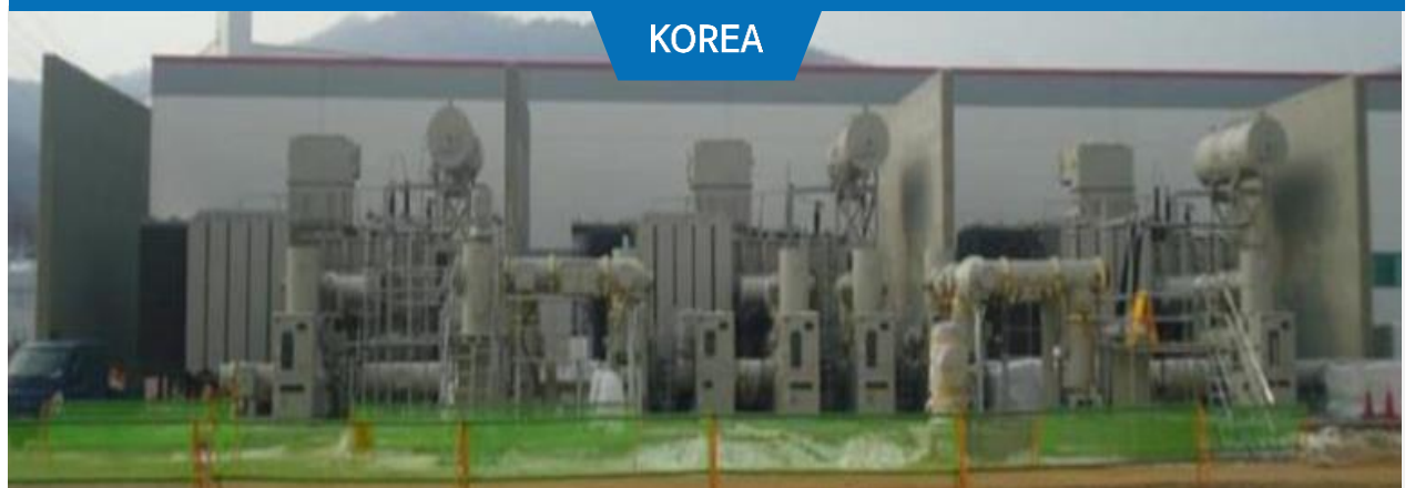
154KV 125MVA LG Display Paju
