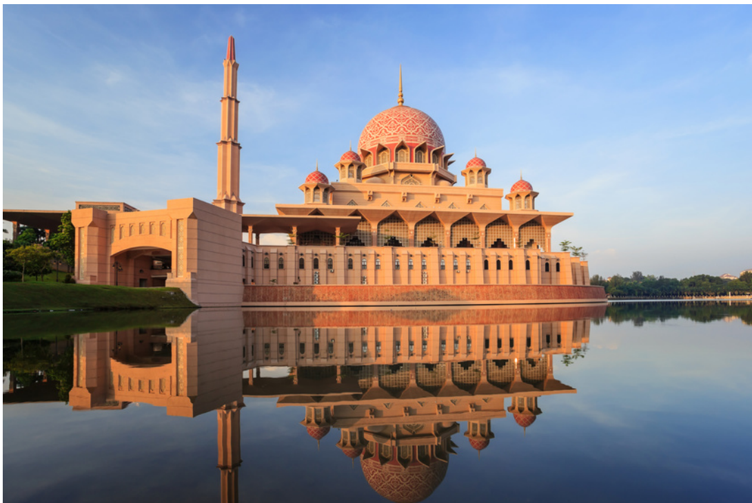
Masjid Putra, Putrajaya
