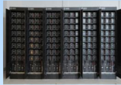
电池储能 Battery
