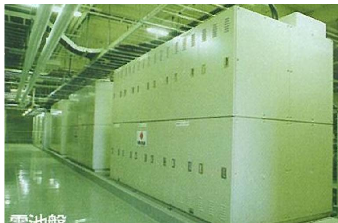
苫前WF設置のレドックスフロー電池
